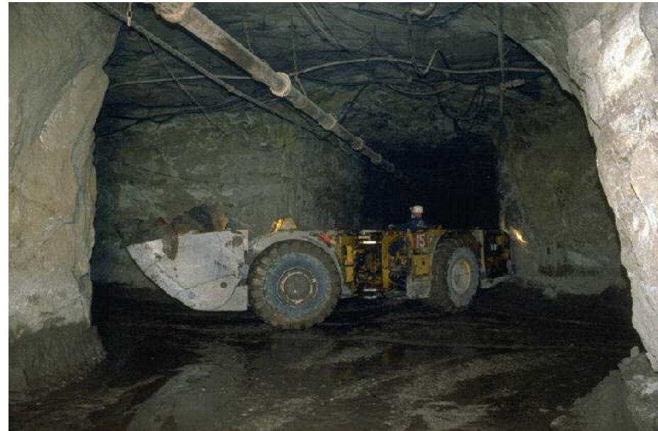
Travaux miniers souterrains (TMS)
